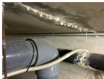
Infiltration d'eau traversant la dalle béton
