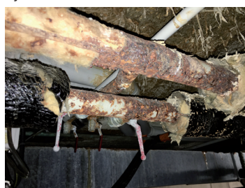
Réseau de distribution d'eau corrodé
