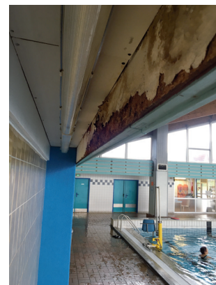
Menuiseries intérieures dégradées
