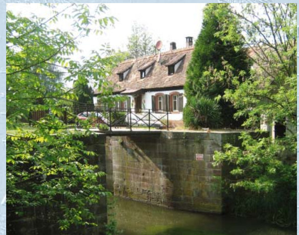
Aux abords de l'écluse n°2 à Ergersheim.
