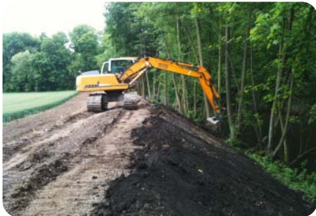
Restauration de la digue d'AVOLSHEIM
