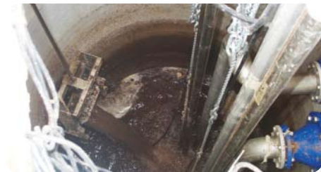
Station de pompage à ERGERSHEIM
