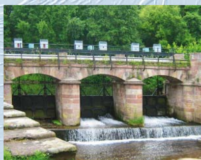
(7) Le vannage ouvrant la "saignée de décharge des eaux", vu de l'aval.
