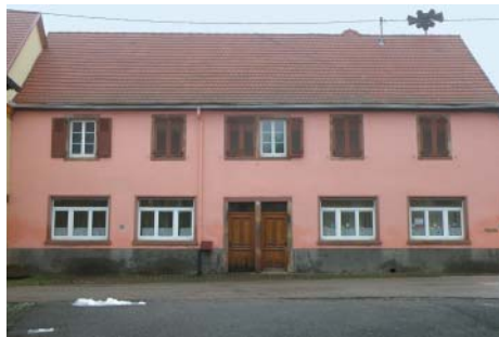
Immeuble à AVOLSHEIM – ancienne école
