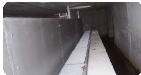
Déversoir d'orage rue des Jardiniers à MUTZIG
