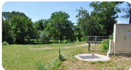
Bassin dépollution enterré à ERGERSHEIM
