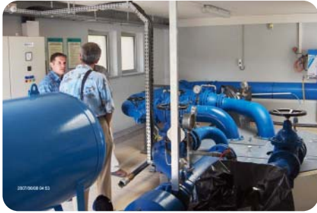
Tête de Puits du Forage de GRESSWILLER
