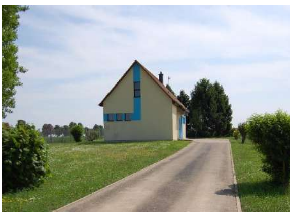
Station de pompage et traitement Altorf 2
