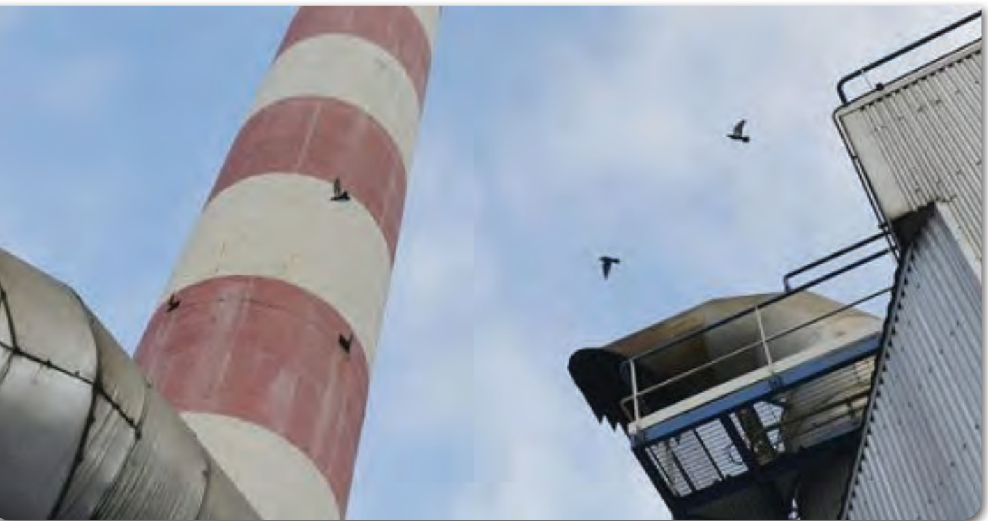
Usine de Valorisation Énergétique exploitée par Sénerval déléguataire de l'Eurométropole de Strasbourg
